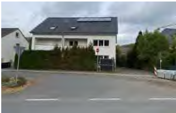
Abb. 68 | Substanzschäden Seitenarm Hollager Straße
