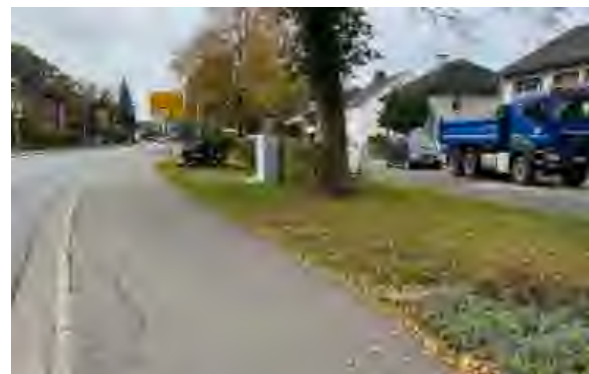
Abb. 72 | Substanzschäden Seitenanlagen Hollager Straße
