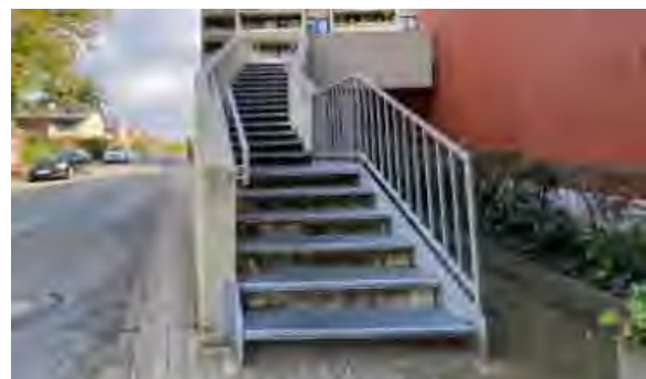
Abb. 80 | Gehweg der Fiesteler Straße ist durch Treppenanlage des Mehrfamilienhauses Adenauer Allee 9-13 unterbrochen
