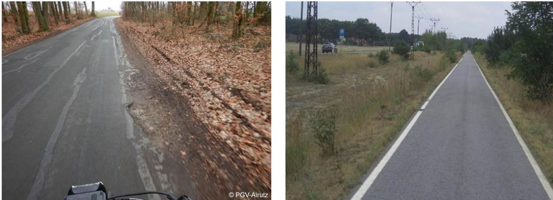
Abb. 6-35: Fiesteler Straße mit starken Abbruchkanten (links) und Beispiel für Fahrbahnrandmarkierungen (rechts)
