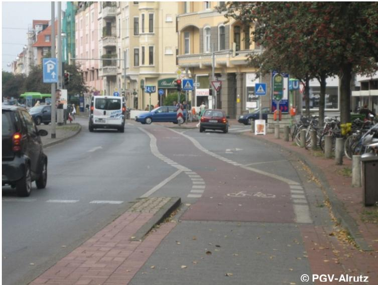
Abb. 6-17: Übergang Radweg in Radfahrstreifen an signalisiertem Knotenpunkt (Hannover)
