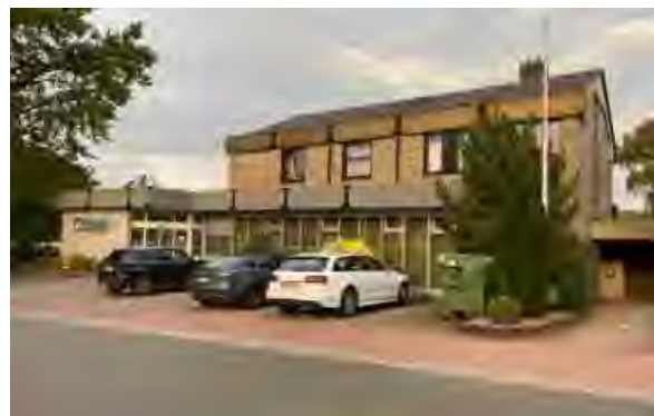
Abb. 56 | Gestalterische Defizite Berstraße 1A
