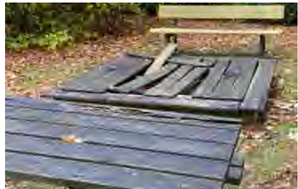
Abb. 75 | Verwahrloste Spielflächen: Mehrfamilienhaus In den Dillen 13-17
