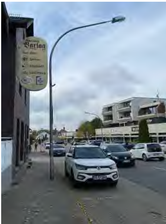
Abb. 62 | Engstelle im Gehweg Hollager Straße 121
