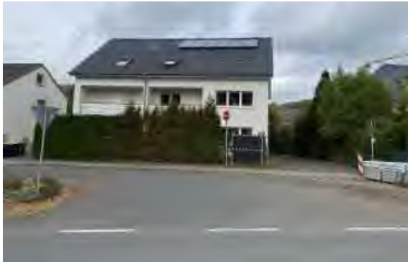
Abb. 47 | Substanzschäden Seitenarm Hollager Straße
