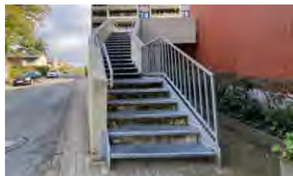
Abb. 59 | Gehweg der Fiesteler Straße ist durch Treppenanlage des Mehrfamilienhauses Adenauer Allee 9-13 unterbrochen
