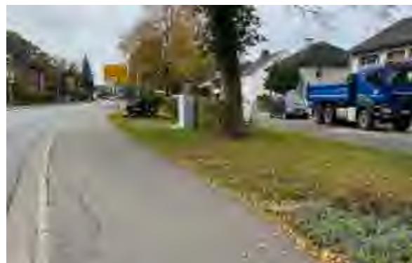
Abb. 51 | Substanzschäden Seitenanlagen Hollager Straße
