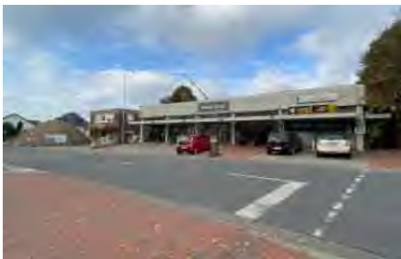
Abb. 19 | Einzelhandelszeile Hollager Str. 138; Baustelle am linken Bildrand neben der Bäckerei Strößner
