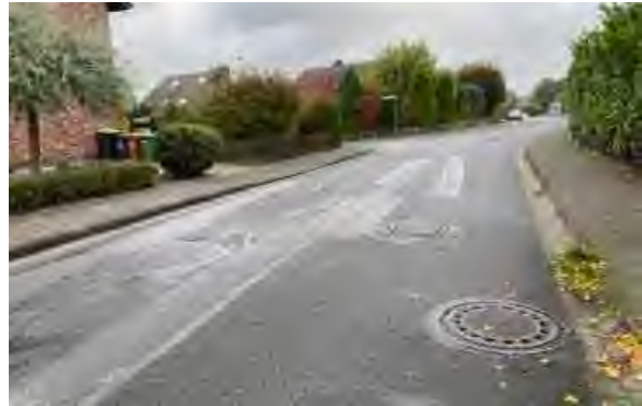
Abb. 50 | Substanzschäden Fiesteler Straße
