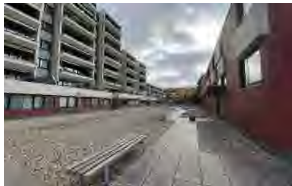
Abb. 81 | Versiegeltes und ungestaltetes Dach der Tiefgarage Mehrfamilienhaus Adenauer Allee 9-13
